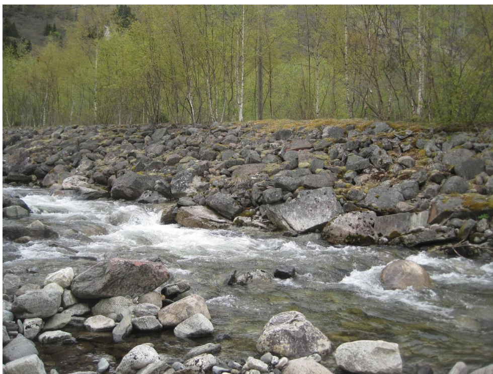
Figur 15. Flomsikring/elveforbygning i midtre del av den undersøkte strekningen.
